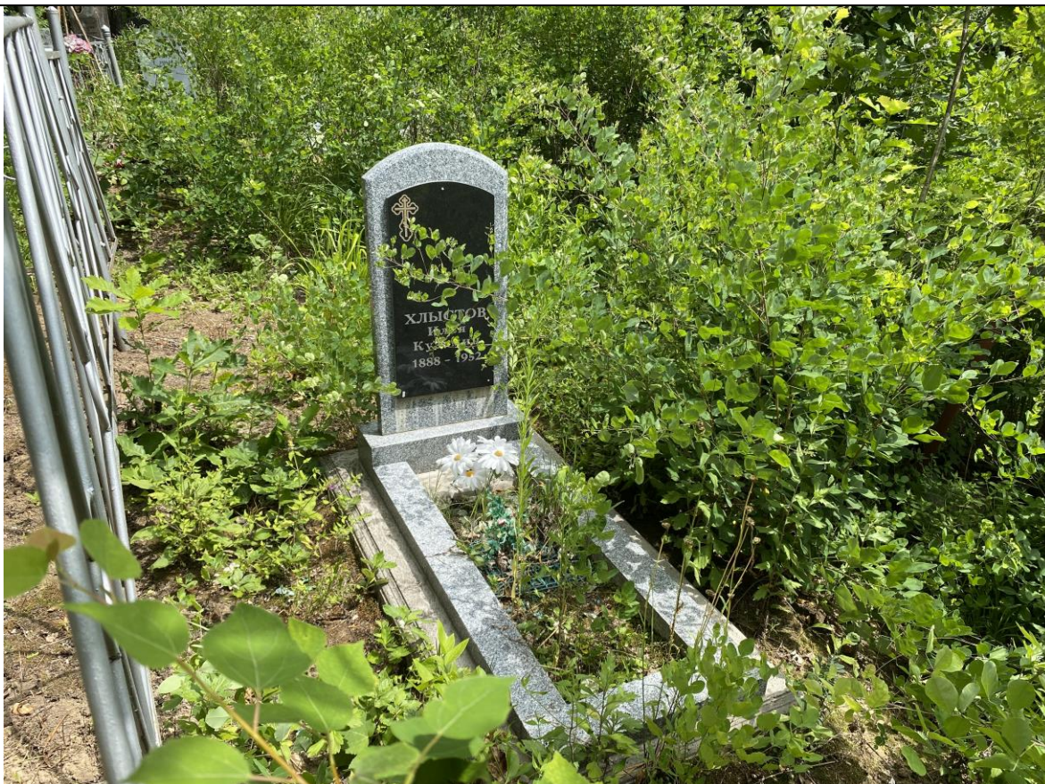
Фото 15. Захоронение Хлыстова Ильи Кузмича (1888-1952). Имеются обрушения грунта слева от захоронения на расстоянии 0,5м. Большая вероятность полного обрушения захоронения в овраг.
